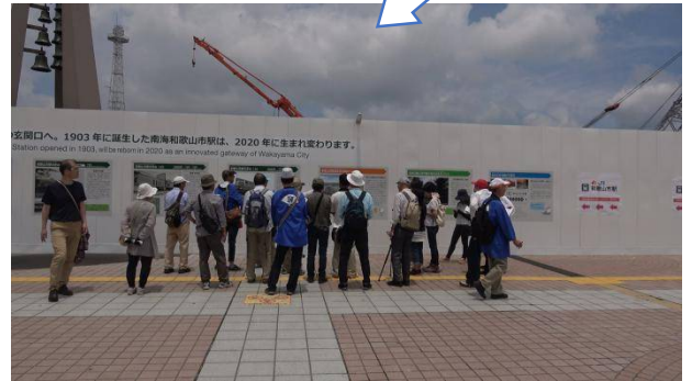
改築中の南海和歌山市駅
